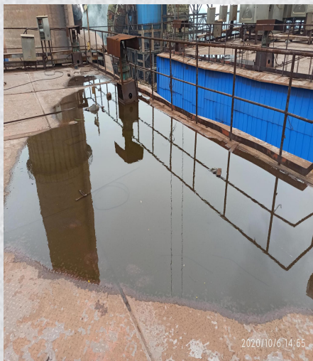
除尘器顶盖积水，灰仓板结严重
