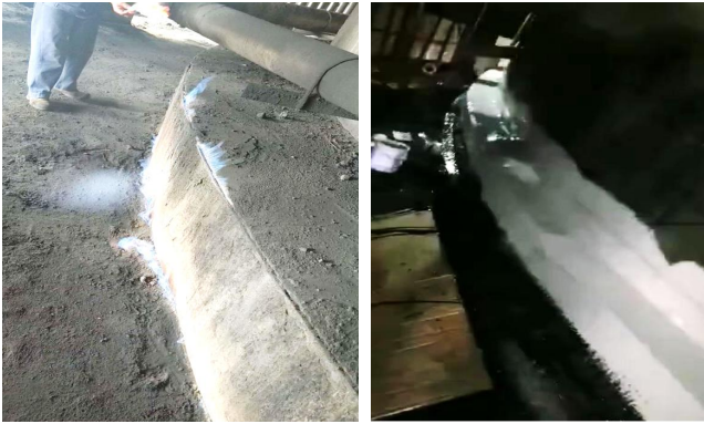
高炉炉皮炉基治理前（左）后（右）
